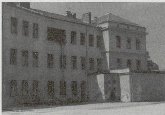
Das Schulzentrum St. Joseph vor der Renovierung – in desolatem Zustand
